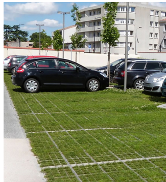
Parking en dalles engazonnées.
