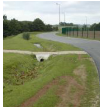
Noue engazonnée en bas coté de route.
