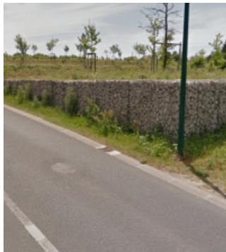
Soutènement en gabions.
