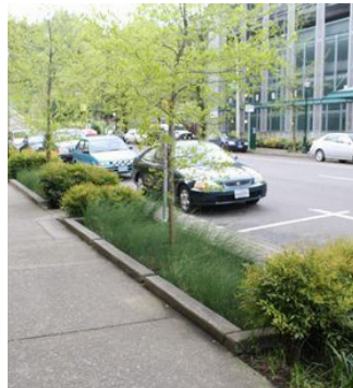
Séparation et infiltration, Portland.
