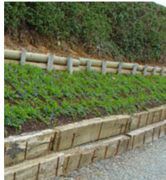
Soutènement moitié bois moitié végétalisé.
